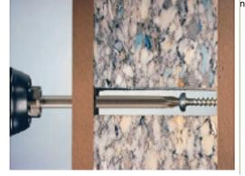
Achten Sie dabei auf den Abstand der einzelnen 6cm breiten Akustikriegel. Die Gipskartonplatten die als letzte Schicht aufgeschraubt werden, haben im Baumarkt Standardbreiten von 1200mm bzw. 1250mm. Daher müssen die Akustikriegel entsprechend im Achsmaß 600mm bzw. 625mm an der Wand verschraubt werden, damit die Gipskartonplatten danach genau darauf geschraubt werden können.
