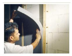
Sie sollten die komplette Fläche zwischen den Akustikriegeln mit den Schalldämmmatten auskleiden, damit keine Lücken entstehen durch die der Schall durchdringen kann. Die Höhe der Akustikriegel und die Schaumstoffplatten können Sie selbst zuschneiden (die Akustikriegel z.B. mittels Säge oder Stichsäge und den Schaumstoff mittels großer Schere). So können Sie das Set an Ihre Raumhöhe optimal anpassen.
